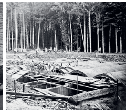
Erstes Wasserreservoir auf 579 m ü. M. im Bau.
