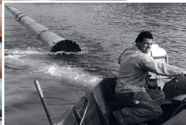
Wasserleitungen werden verlegt.
