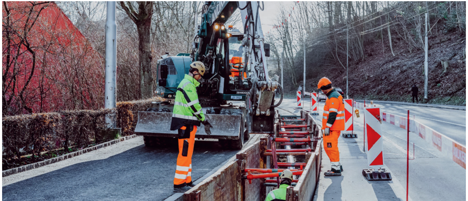
Leitungsbau für See-Energie beim Eiszentrum Luzern.
